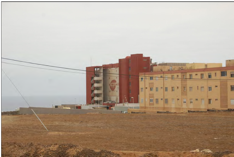
Figura 3b. Resumen fotográfico de caracterización general. Margen Oeste del ámbito.
