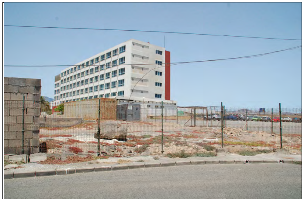
Figura 17c. Función de equipamiento sanitario del ámbito
