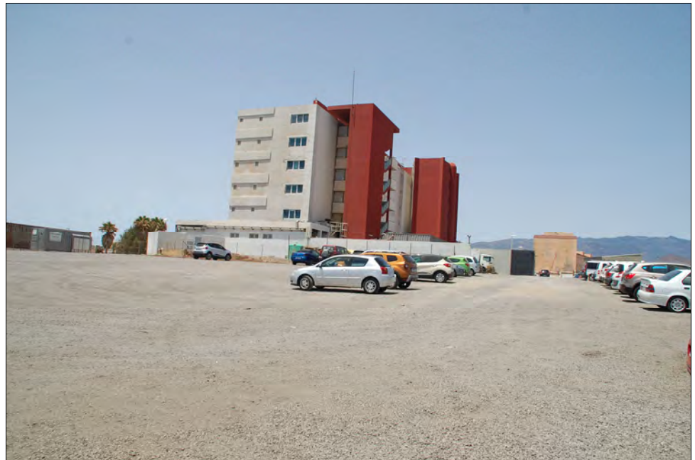
Figura 3a. Resumen fotográfico de caracterización general. Margen Este del ámbito
